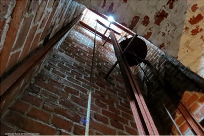
Шахта подъёмника снарядов
